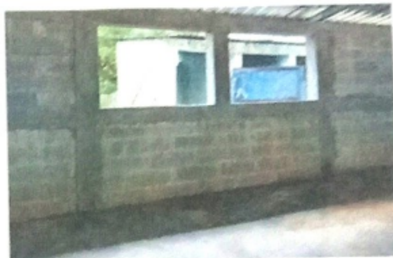
Foto 2: Mejoramiento de la cocina
