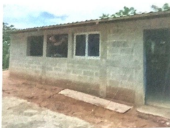
Foto 3: Instalacion de ventanas y puerta
