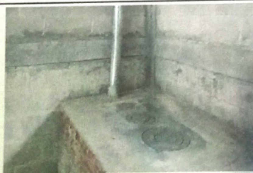
Foto 5: Instalacion de plancha de metal para el polletón
